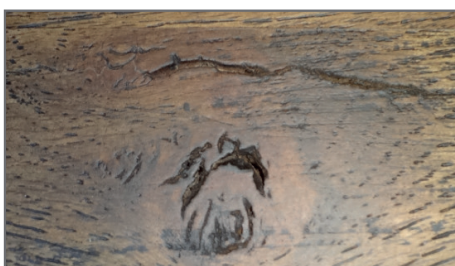
Wuchrisse und Äste mit Rissen.
